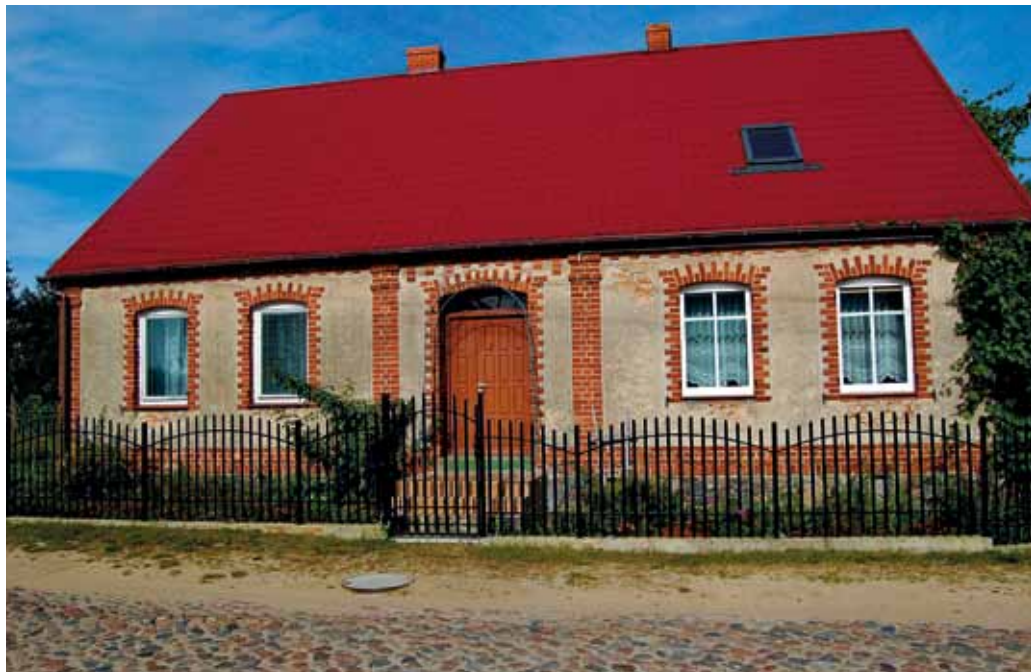
Fot. 12. Wieś Zatom. Murowana chata szerokofrontowa z detalem ceglany
