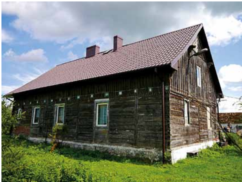
Fot. 2. Wieś Folsztyn. Konstrukcja sumikowo-łatkowa z zamkiem węglowym
