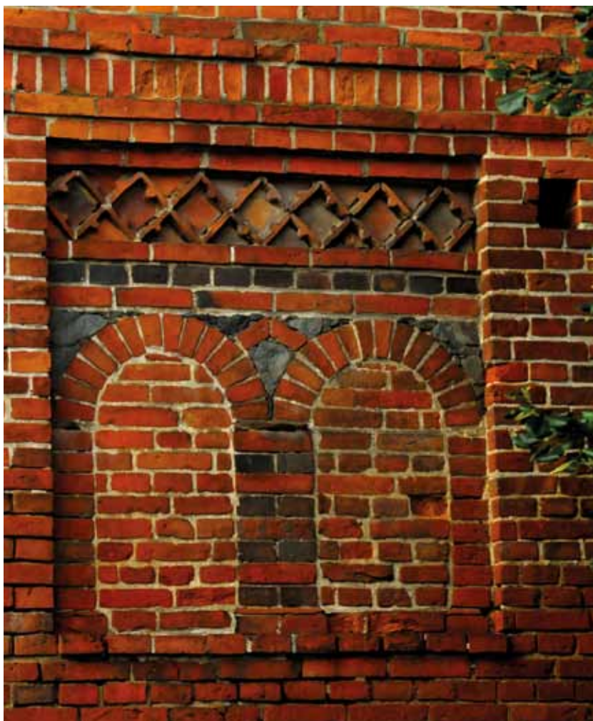
Fot. 9. Wieś Górzno. Detale ceglane z zendrówką, kawałkami dachówek i kamienia
