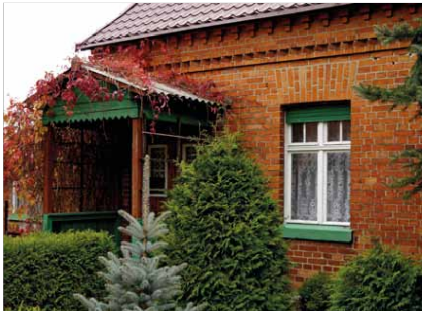
Fot. 35. Wieś Chłopowo. Ganek wejściowy
