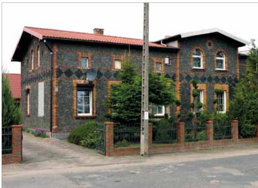
Fot. 19. Wieś Rębusz. Ściana z geometryczną okładziną kamienną i ceglany detal
