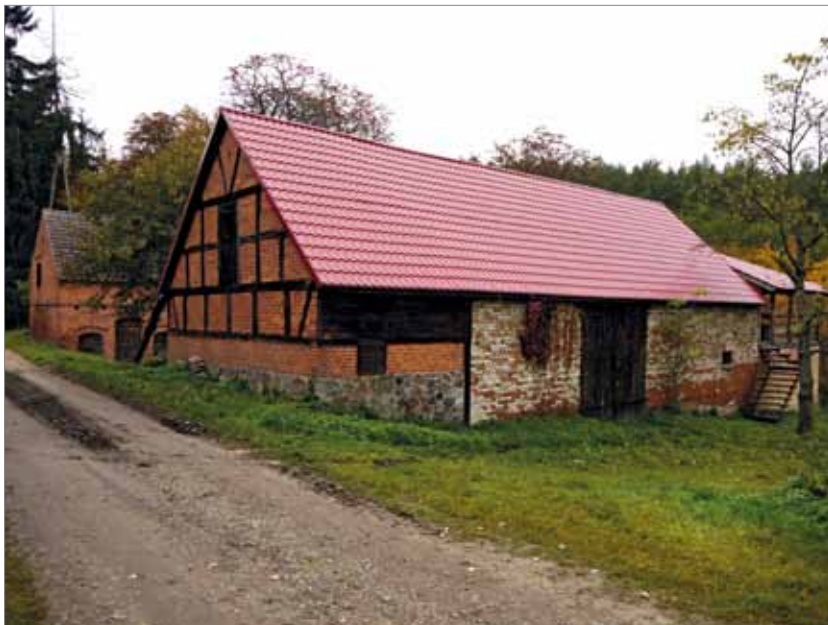
Fot. 17. Wieś Dolinka. Stary budynek kryty błyszczącą dachówką esówką
