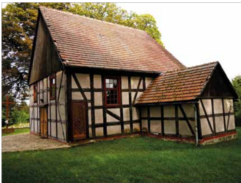
Fot. 16. Kościół w Zdbowie. Zestawienie dachówki zakładkowej i karpówki
