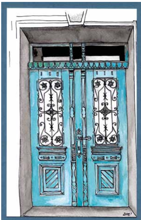
Rys. 3. Wieś Wygon. Drzwi dwuskrzydłowe z naświetlem i kutą kratą (rys. Kaja Cykalewicz)
