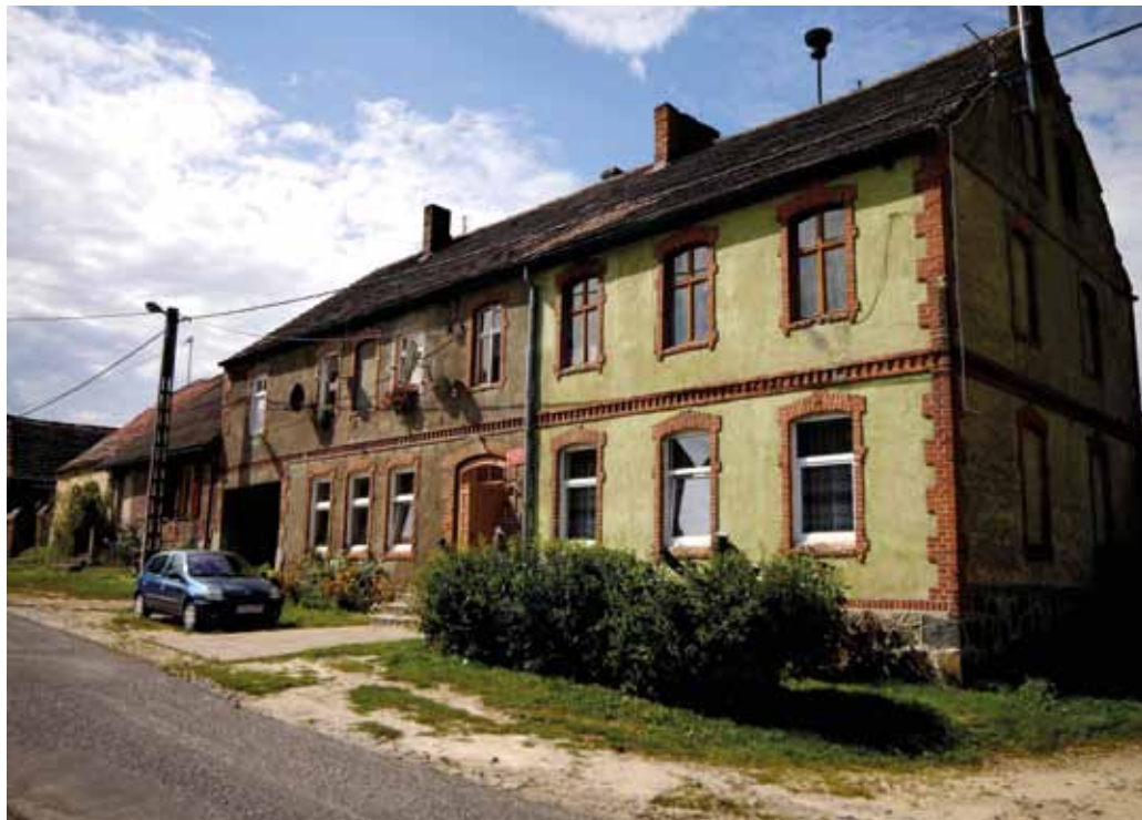
Fot. 8. Wieś Strzalin. Elewacja tynkowana z ceglany detalami
