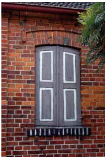
Fot. 29. Wieś Radęcin. Proste okiennice płycinowe mocowane wewnątrz ościeża
