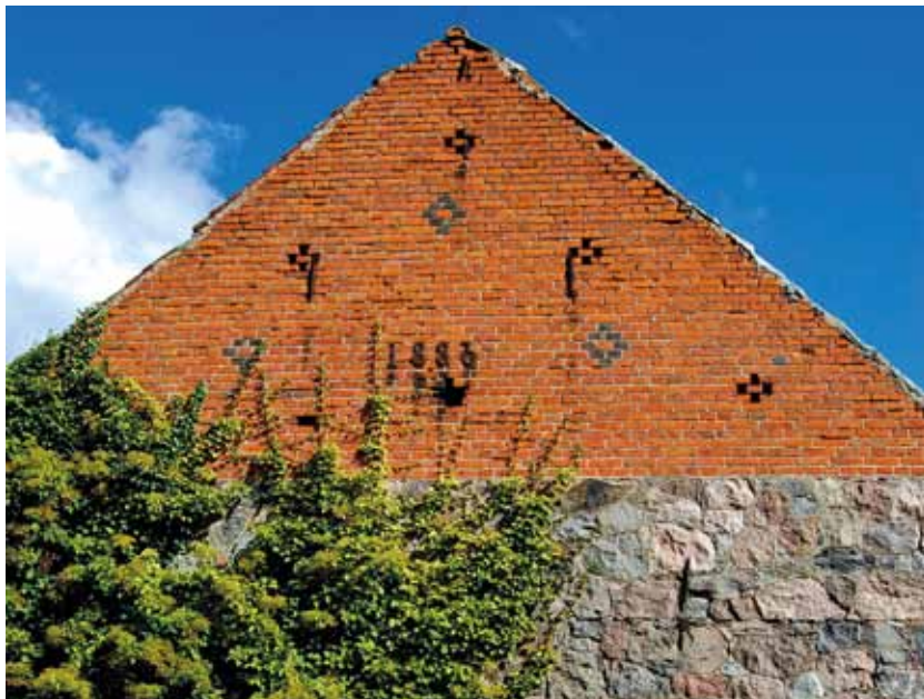
Fot. 12. Wieś Dominikowo. Kuty datownik w szczycie budynku gospodarskiego
