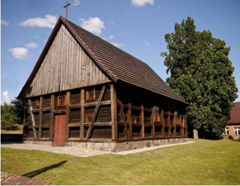
Fot. 11. Drewniany z konstrukcją ryglową kościół we wsi Herbertowo
