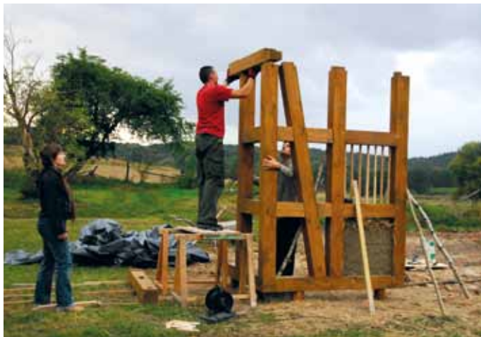
Fot. 9. Młyn-Papiernia, stawianie ścianki ryglowej, EDD 2009 r.
