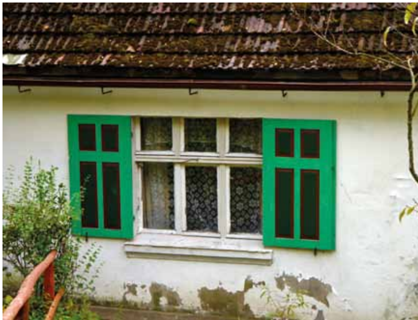
Fot. 31. Wieś Ostrowiec. Okiennice płycinowe malowane na trzy kolory
