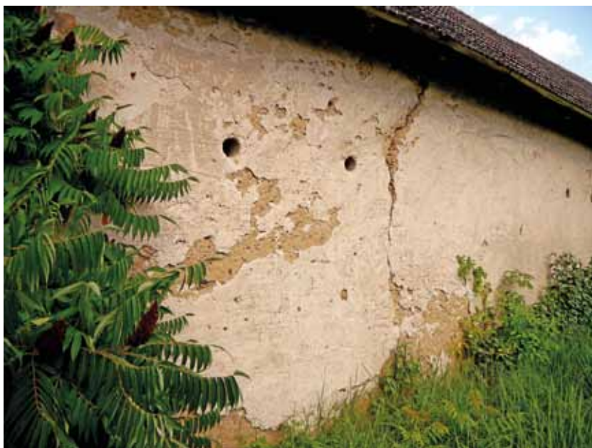
Fot. 12. Wieś Dzierżążno Małe. Mur gliniany
