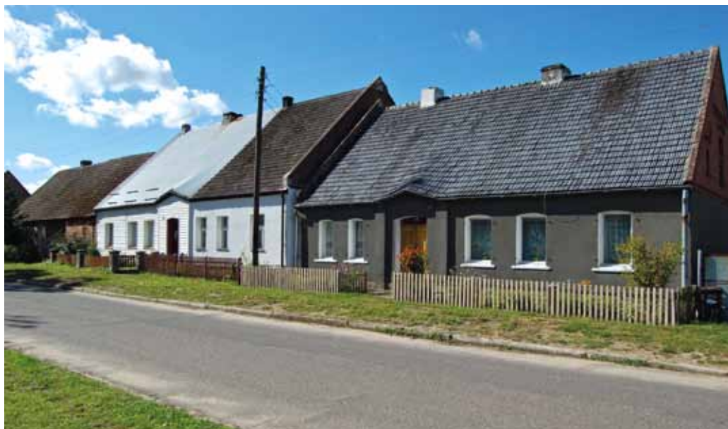
Fot. 4. Wieś Żółwino. Charakterystyczne podgięcie okapu nad wejściem do budynku
