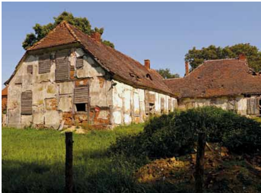
Fot. 1. Ruina zabytkowego dworu w Kiełpinie
