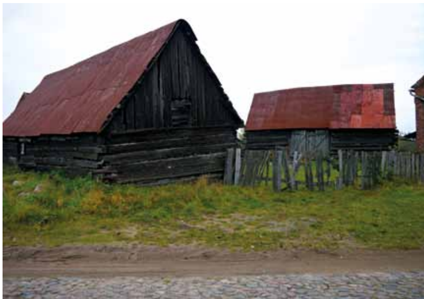
Fot. 1. Wieś Drawiny. Konstrukcja wieńcowa słowiańska
