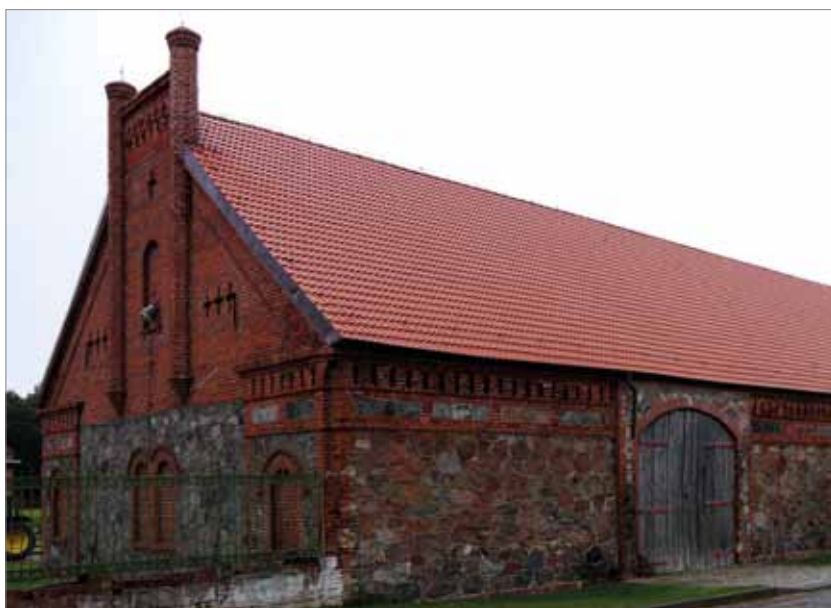
Fot. 3. Wieś Próchnowo. Bogaty detal ceglany w szczycie budynku
