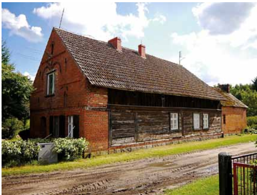
Fot. 3. Wieś Folsztyn. Konstrukcja sumikowo-łatkowa ze szczytem ceglany
