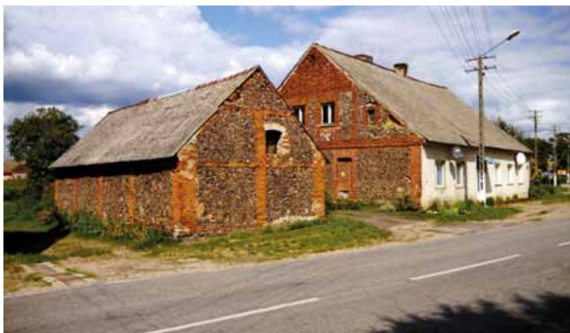
Fot. 17. Wieś Siedlisko. Ściana z okładziną kamienną dzieloną na pola pasami cegły
