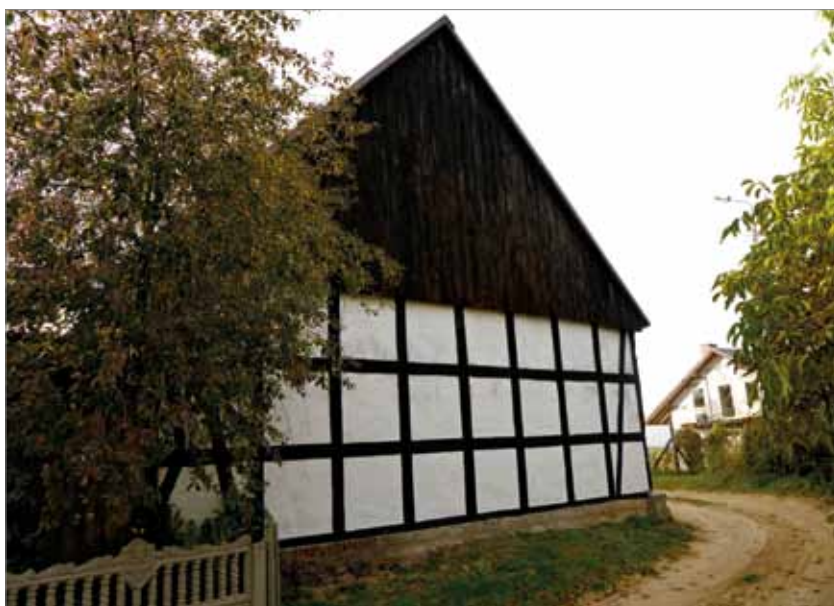
Fot. 6. Wieś Ostrowiec. Klasyczny przykład konstrukcji ryglowej „szachownica”
