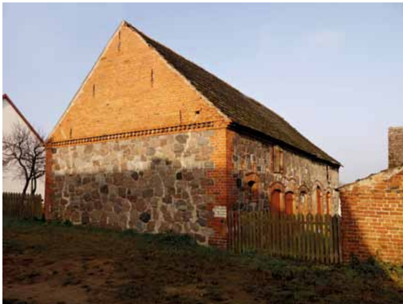
Fot. 7. Wieś Kolki. Mieszana konstrukcja ścian kamiennie ceglana
