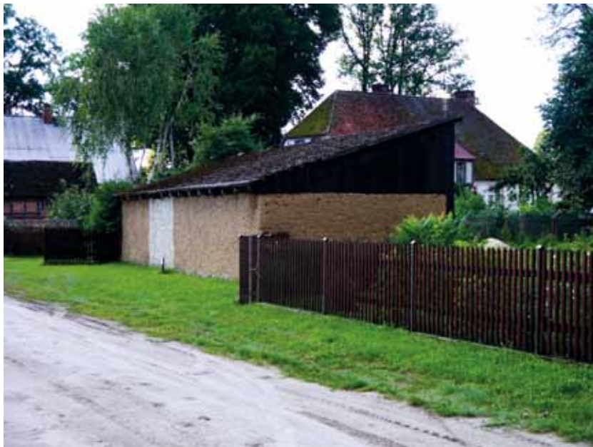
Fot. 11. Wieś Dzierżążno Małe. Mur gliniany
