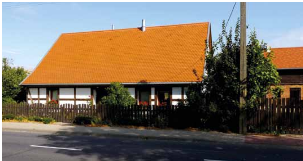
Fot. 8. Wieś Zieleniewo. Stare czy nowe? Przykład udanej modernizacji starego domu ryglowego
