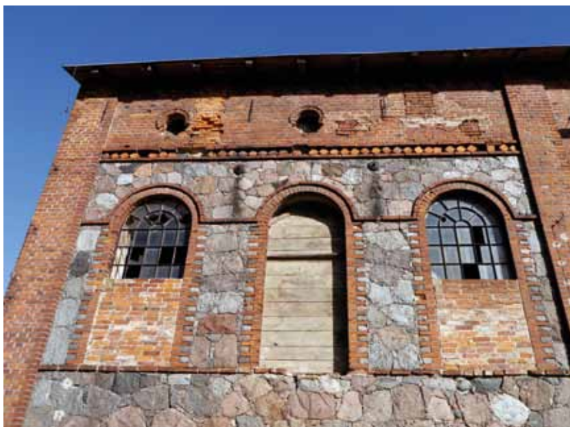
Fot. 4. Wieś Licheń. Budynek w zabudowie folwarcznej
