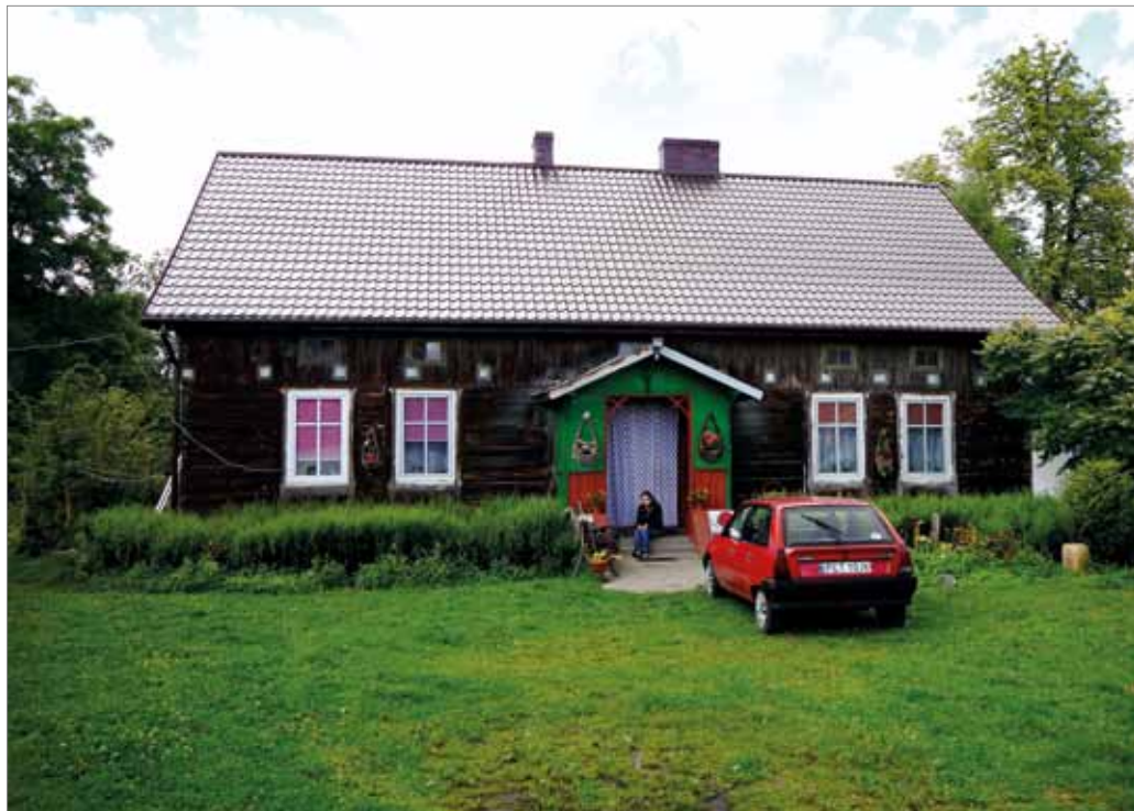
Fot. 6. Wieś Folsztyn – dom drewniany w konstrukcji wieńcowej
