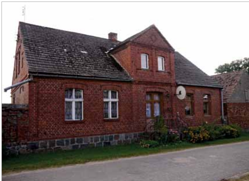
Fot. 19. Wieś Jeziorki. Dachówka betonowa zakładkowa
