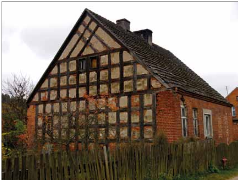
Fot. 6. Wieś Sarbinowo. Dom z krzyżowym układem belek w szczycie
