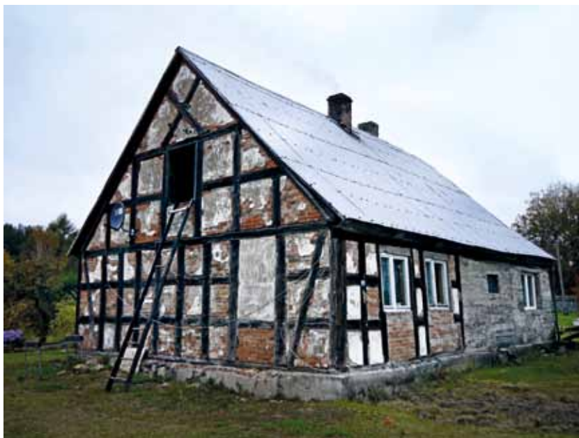
Fot. 5. Wieś Przyborowo. Konstrukcja ryglowa wypełniana cegłą i tynkowaną
