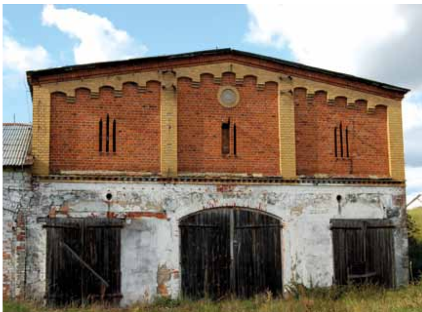
Fot. 7. Wieś Niemieńsko. Różne rodzaje cegły i pilastry w szczycie budynku gospodarczego
