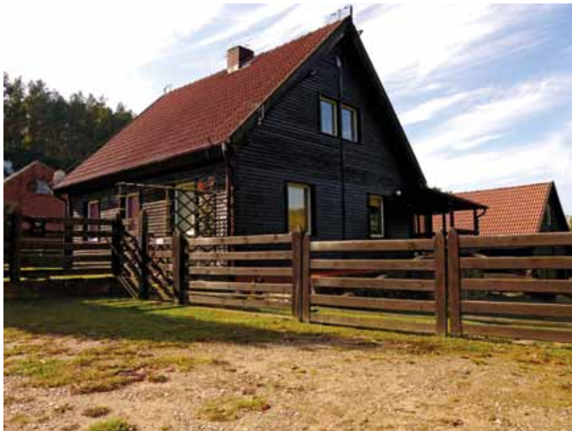
Fot. 4. Wieś Moczele. Konstrukcja ryglowa deskowana od zewnątrz
