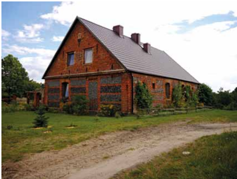
Fot. 10. Wieś Folsztyn. Dom z okładzinami kamiennymi i detalem ceglany
