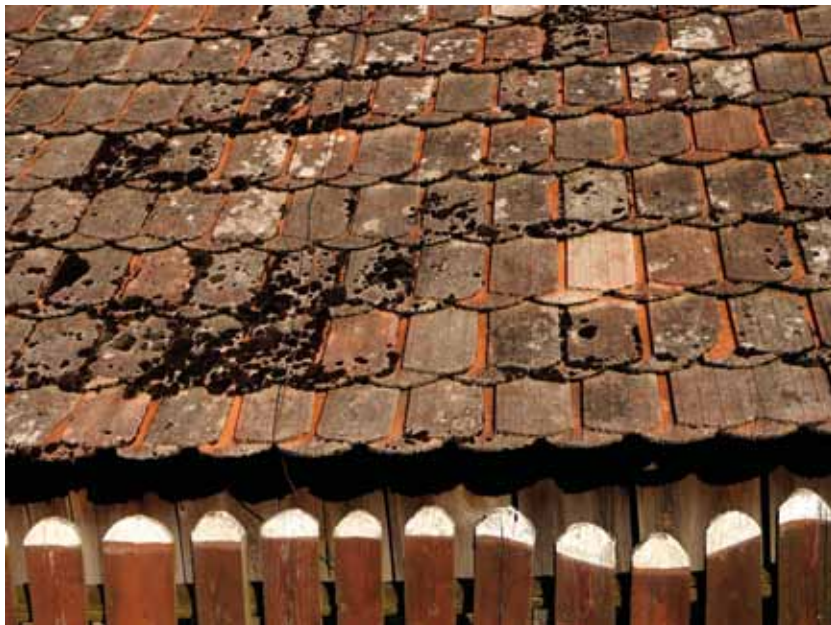
Fot. 15. Wieś Breń. Szczegół dachu krytego karpówką ułożoną w koronkę
