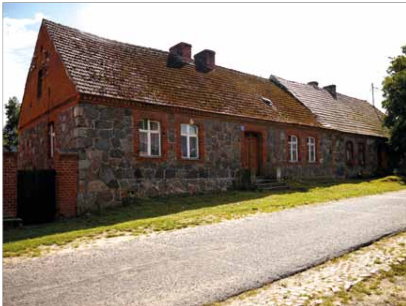
Fot. 18. Wieś Strzaliny. Elewacja kamienna z ceglany detal
