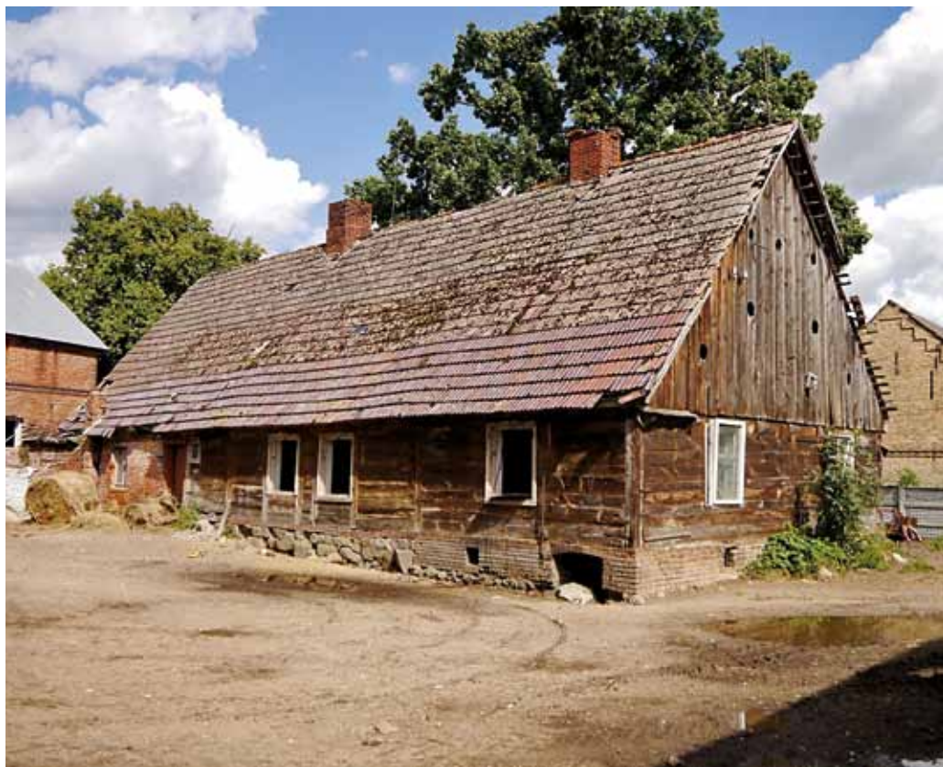
Fot. 7. Wieś Folsztyn. Dom drewniany w konstrukcji sumikowo-łątkowej
